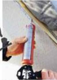
Die Luft-Durchsperrung kann mit systemgerechten Kleb-Dichtstoffen angeschlossen werden.
